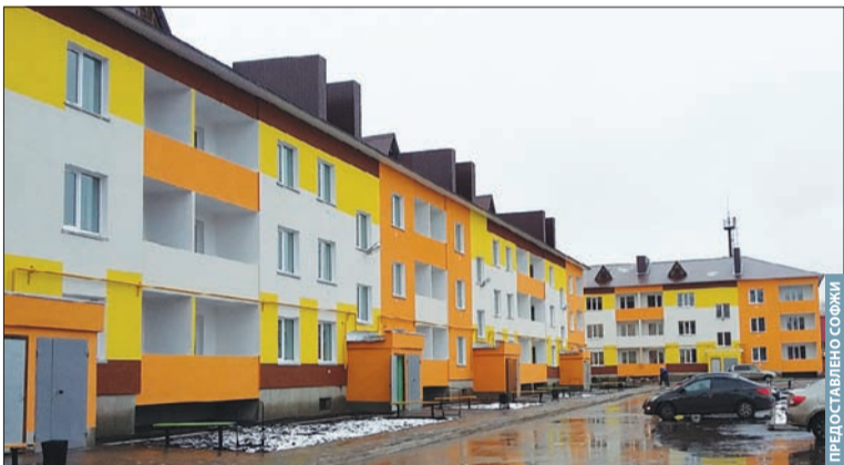
г. Отрадный. Дома, построенные СОФЖИ в рамках реализации программы переселения из аварийного жилищного фонда. Ноябрь 2015 г.
