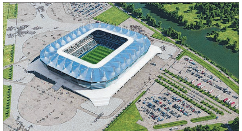
Проект «Стадиона Калининград» в ноябре вышел из госэкспертизы. Строительство только началось
