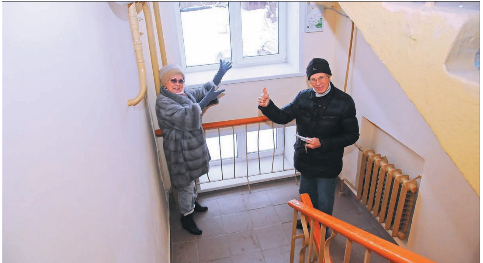
Благодаря программе капремонта жилья за последние полтора года у нас отремонтировано больше жилья, чем за предшествующие 6 лет. В 2016 году в планах на ремонт еще 1157 домов
